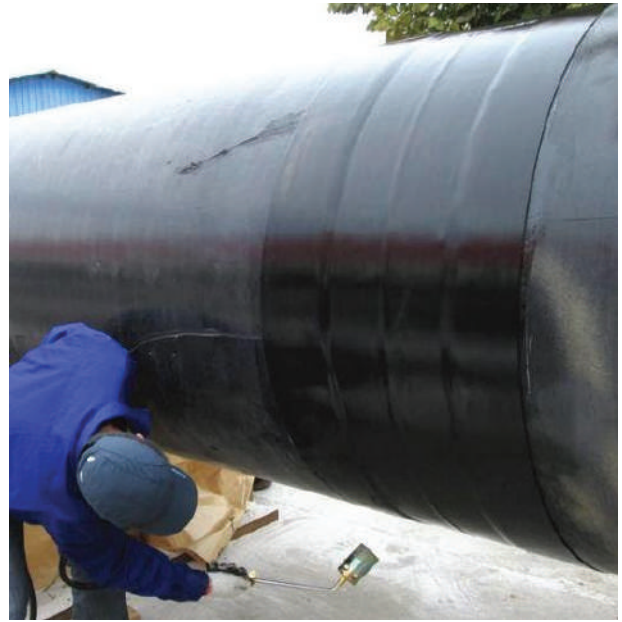
តំណទុយោលូ PE Sleeve for Sewage Pipe
